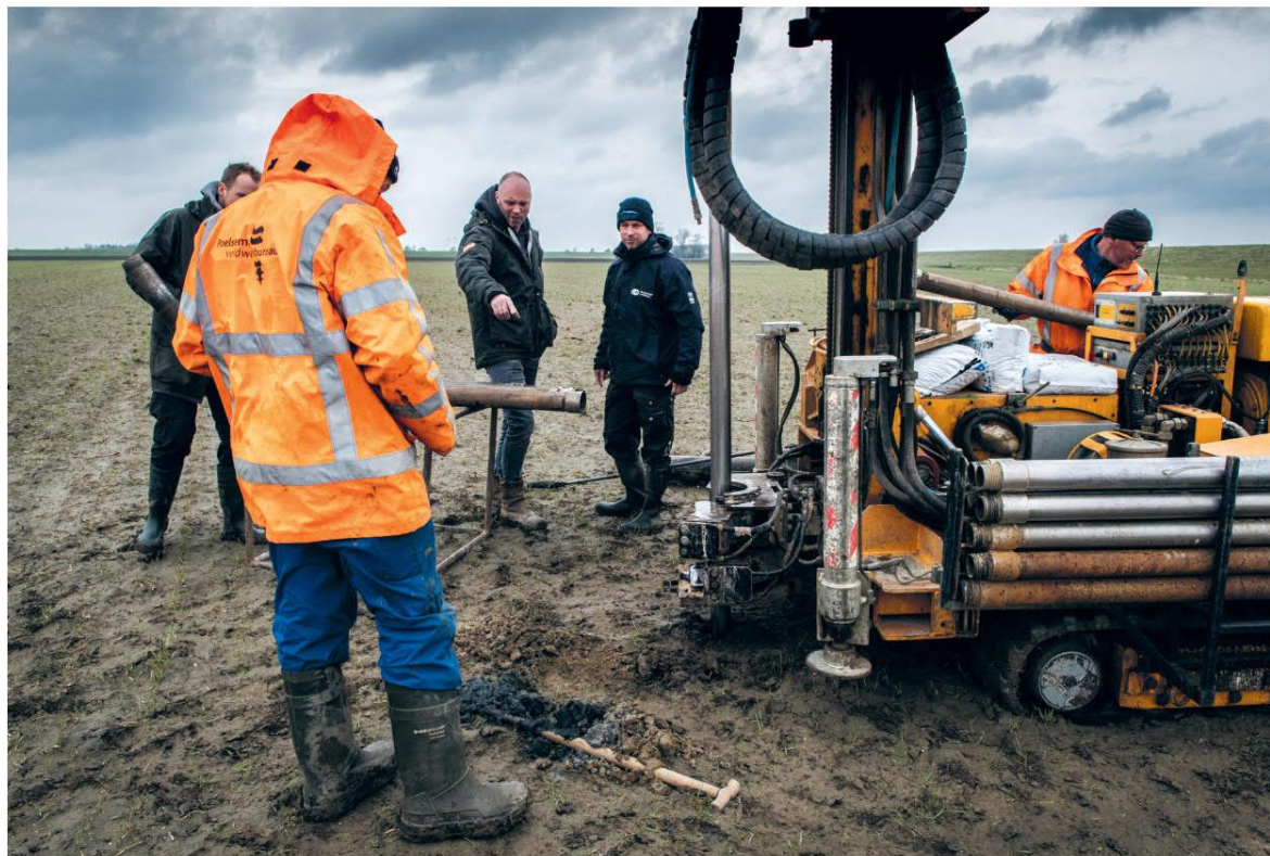
Peilbuizen worden 7 tot 10 meter onder maaiveld geplaatst in akkerbouwland bij Termunten.
